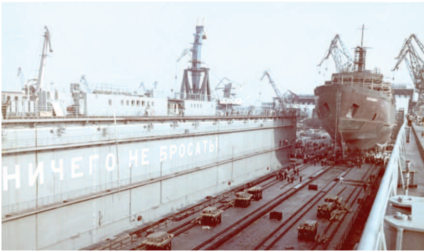
Рис. 8. Накатка парома «Сахалин» на плавучий док «Балтика»
