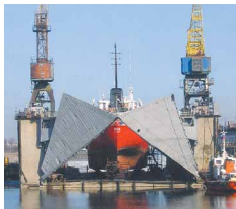
Рис. 2. Железобетонный плавучий док грузоподъемностью 4000 т, построенный в 1933 г.
