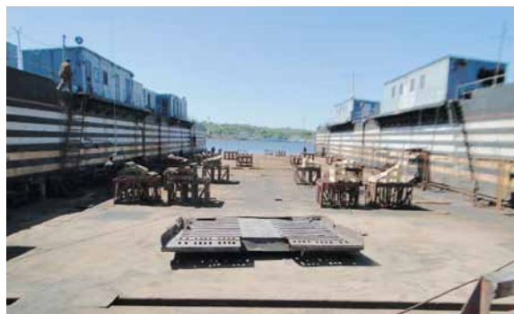
Рис. 1. Металлический плавучий док грузоподъемностью 1000 т, построенный в 1910 г.
